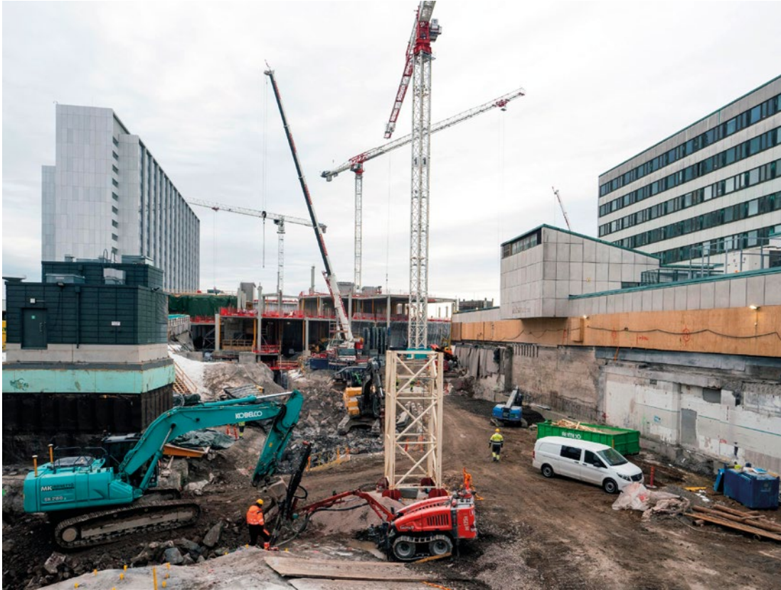
Siltasairaalan työmaa Helsingin Meilahdessa vuonna 2019.
